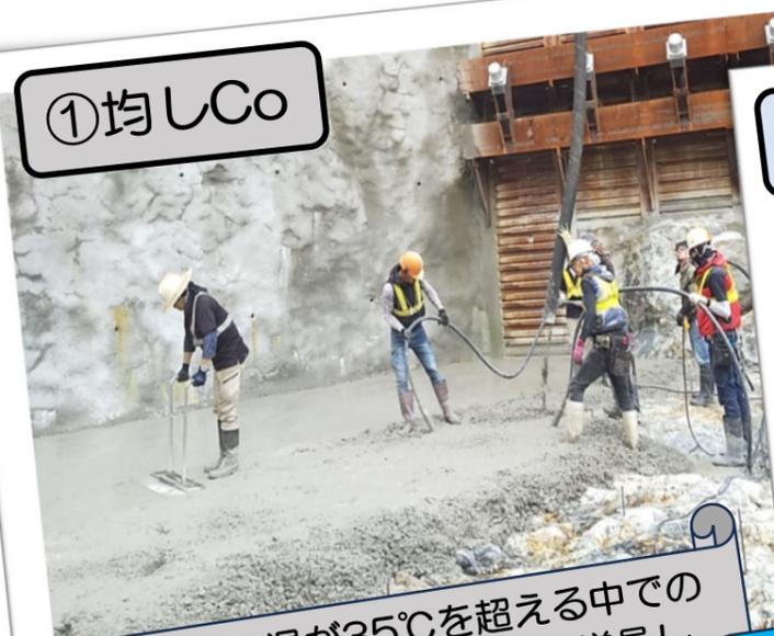
現場内の気温が35℃を超える中での作業になったので、作業員も増員して、Co打設と均し作業を並行して進めていきました！
