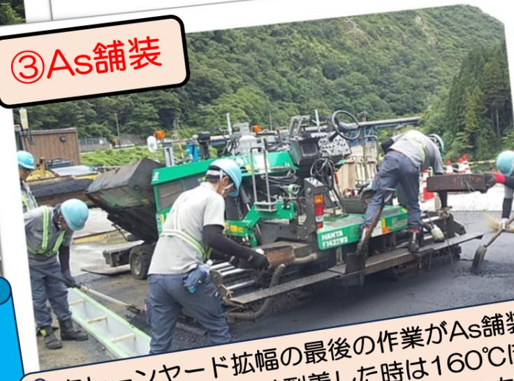
クレーンヤード拡幅の最後の作業がAs舗装です！アスファルトは到着した時は160℃ほどあり、現場内気温35℃とのWパンチにも耐えながら作業を行っています！！
