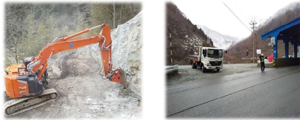
◆A2橋台：岩掘削、残土運搬状況
