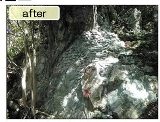
・この工法は、不安定になっている岩を接着剤を用いて、接着して一体化させることで安定化を図り、落石とならいようにしています。
