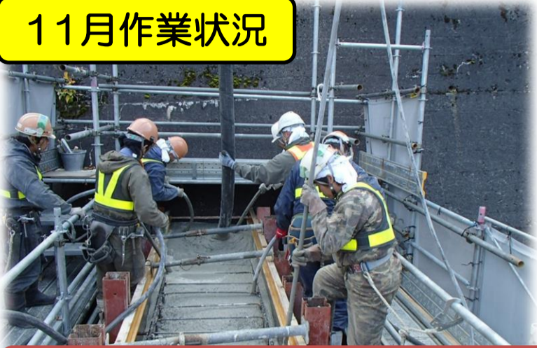
最後のコンクリート打設
